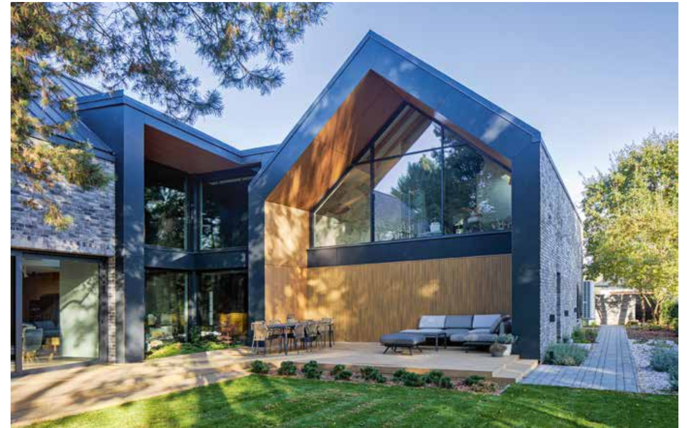
W ścianach szczytowych obu brył wycięto obszerne podcienia wyłożone jasnymi płytami drewnopodobnymi HPL, które rozjaśniają elewacje, a przy okazji tworzą naturalny klimat sprzyjający relaksowi w urządzonych tam tarasach, częściowo zadaszonych
