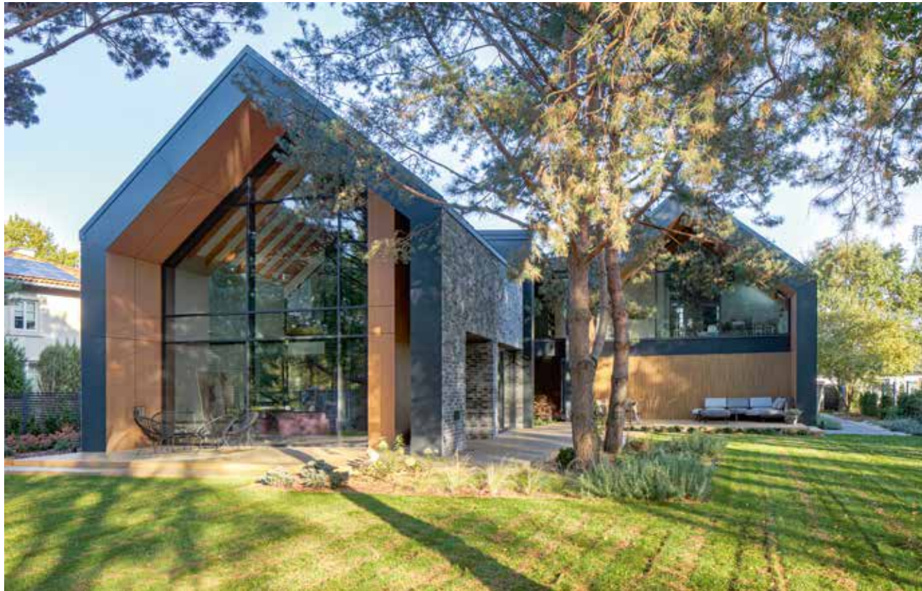
Dom tworzą dwie stodalane bryły, połączone ze sobą, tu w widoku od ogrodu. Większa, po lewej, zawiera część dzienną, a na piętrze przewidziano przestrzeń prywatne gospodarzy. Mniejsza kryje w sobie garaż, a nad nim królestwo dwojga dzieci
